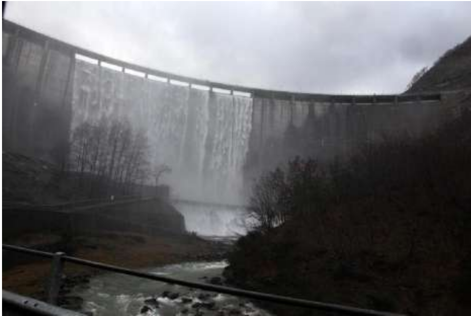
Figura 2 – Diga di Ridracoli, con tracimazione naturale tramite scarichi di superficie
